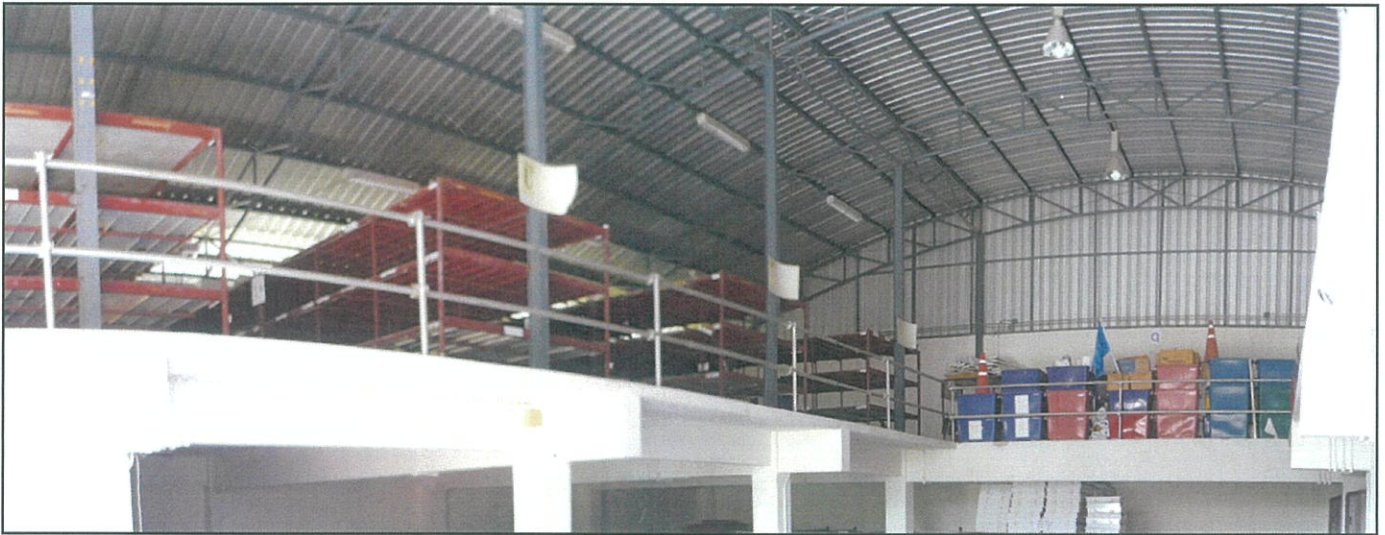
สภาพภายใน ห้องโถงที่เก็บของ ชั้นบน
