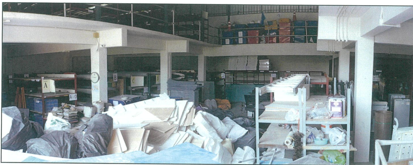
สภาพภายใน ห้องโถงที่เก็บของ ชั้นล่าง
