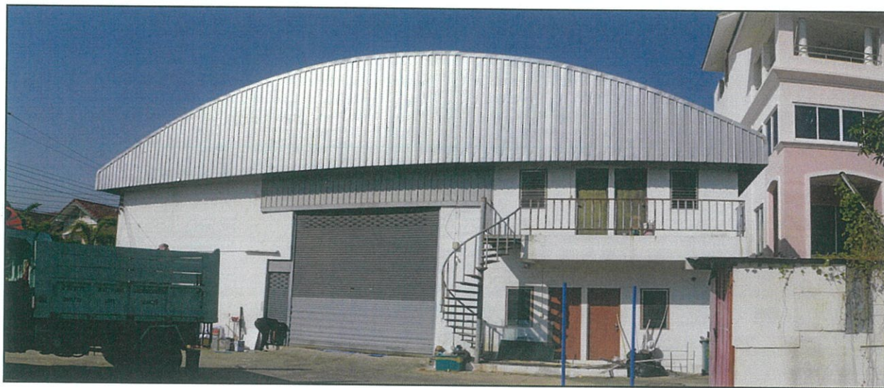
สภาพทั่วไป อาคาร โกดัง 2 ชั้น
