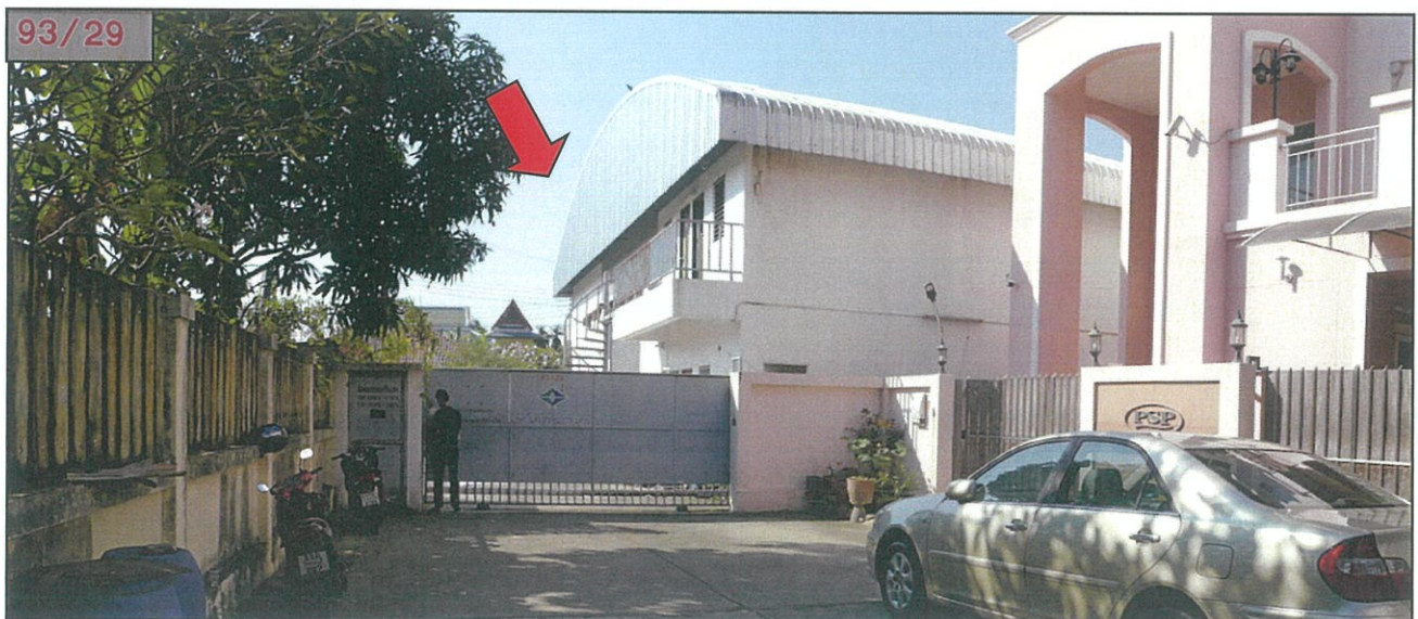
สภาพทั่วไป อาคาร โกดัง 2 ชั้น
